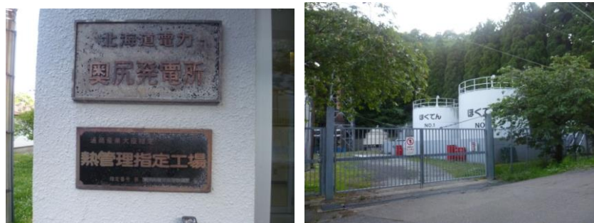
写真-6 ①離島の電力施設状況の調査(北海道電力奥尻発電所(4,000kWディーゼル発電))
